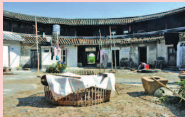
▲ 紫來樓內圍樓現狀。
